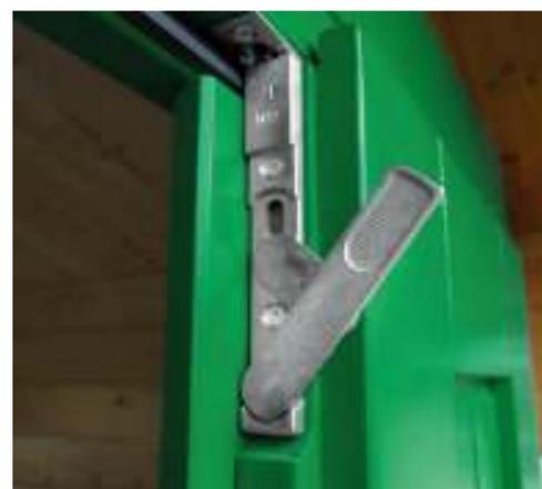
Massive Türen mit mittiger Türfüllung und Gummidichtung. Türschloss mit Profilzylinder und hochwertigen Beschlägen.
