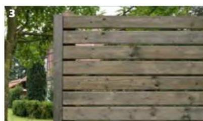
**3.** Beträgt der Abstand der Pfosten mehr als 1,00 m, wird innen als senkrechte Strebe ein Konstruktionsholz 3 x 5 cm angeschraubt (jede Rhombusleiste mit einer Edelstahlschraube fixieren). An den Ecken wird von außen, als Abschlussleiste, ebenfalls ein Konstruktionsholz von 3 x 5 cm gesetzt.
