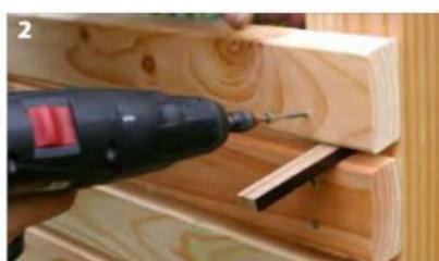
**2.** Setzen Sie das erste Brett mit ausreichend Abstand zum Boden (mind. 5 cm). Jedes Brett wird auf dem Pfosten mit 2 Edelstahlschrauben befestigt. Bereiten Sie als Abstandhalter kleine Leistenstücke vor. Der Abstand auf den Fotos beträgt 10 mm, kann aber frei gewählt werden.
