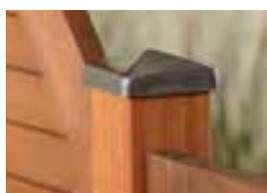
Konstruktiver Holzschutz: Schützen Sie die schichtverleimten Hartholzpfosten zwingend mit Kappen aus Edelstahl, Seite 119.
