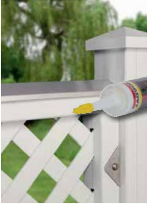
Designaufsatz Alu mit MS-Polymer-Kleber (1398) befestigen.
