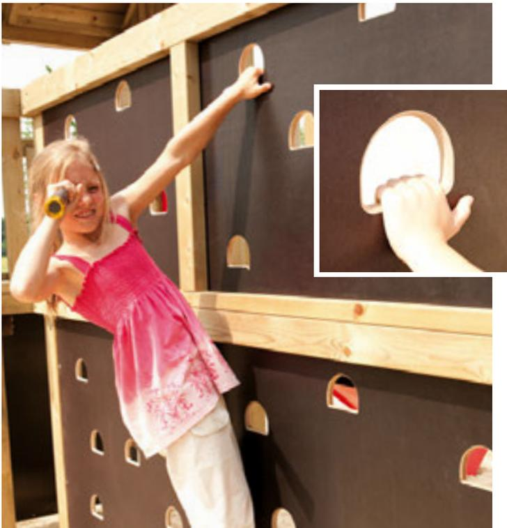
Sicherheit geht vor! Die Kletterwände sind sehr beliebt bei Kindern. Mit unermüdlicher Energie geht es hoch. Wie gut, dass da die Grifflöcher der Kletterwände mit gerundeten Kanten versehen sind.
